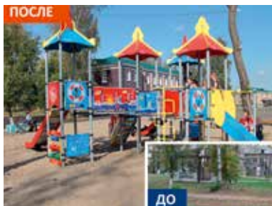
Строительство детской площадки в семейном парке «Радуга» в с. Залесово Залесовского района Алтайского края
