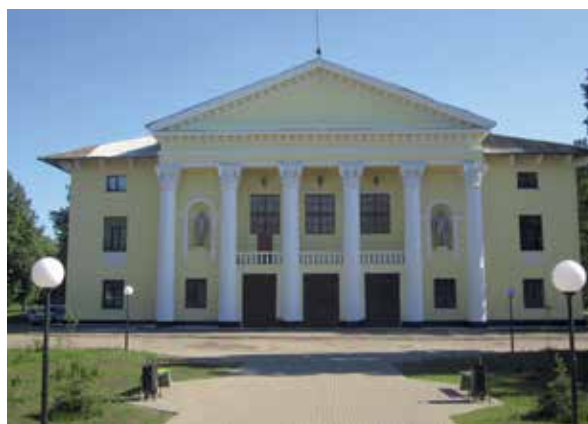
Ремонт Дома культуры и отдыха им. Молодцова, г. Донской, Тульская область
